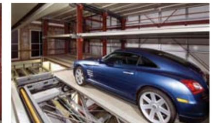
Dopo aver raggiunto lo spazio vuoto nella griglia a doppia fila, il pallet con l'auto viene agganciato al pallet della seconda fila e poi spinto nelle zone di stoccaggio. Una volta che la posizione è stata raggiunta, l'unità di deposito e prelievo si stacca dal pallet.
