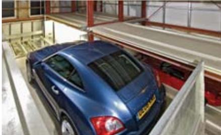
L'ascensore verticale scende e allo stesso tempo l'unità di deposito e prelievo si muove orizzontalmente.
