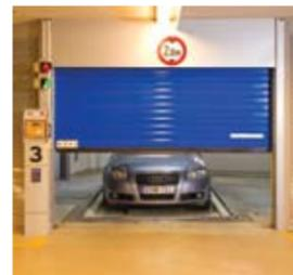
Una volta che l'auto sul pallet ha raggiunto l'area di trasferimento la porta si apre automaticamente.
