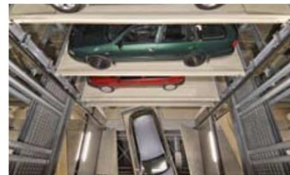
Nell'area di trasferimento il pallet con la vettura viene girato e sollevato.
