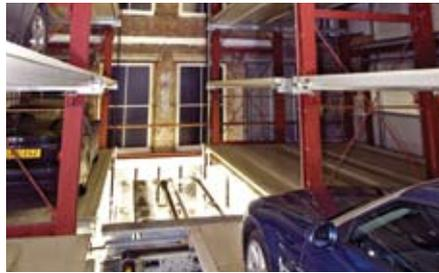
Una volta che l'ascensore verticale ha raggiunto il livello della griglia richiesto, il pallet con l'auto viene posizionato e fissato sull'unità di deposito e prelievo.
