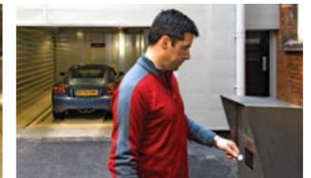
L'utente conferma la procedura di parcheggio al pannello di comando utilizzando il proprio chip. Scanner laser installati sul soffitto dell'area di entrata controllano la corretta posizione dell'auto e successivamente la porta viene chiusa.
